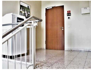
Zugang vom Treppenhaus zum 5. Obergeschoss.
