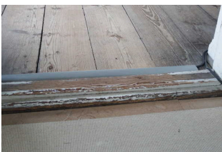
Schwelle an den Türen
