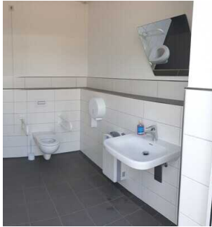
Sanitärgebäude 1: WC und Dusche für Menschen mit Behinderung
