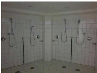
EG: Duschen im Saunabereich
