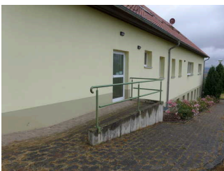
Hintereingang mit Rampe
