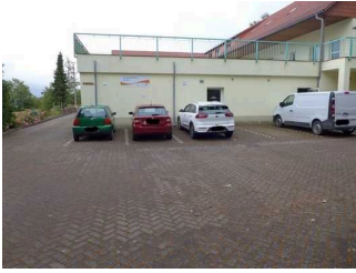
Parkplatz an der Jugendherberge
