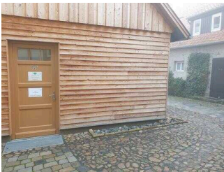
Eingang ins Sanitärgebäude
