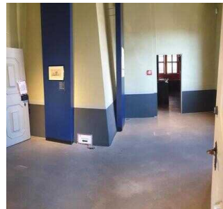
Altbau, 1. OG: Ausstellungsräume
