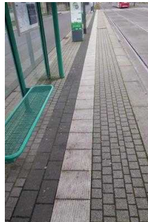
Haltestelle Straßenbahn Messe / Elbauenpark Eingang West
