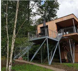
2 Terrassen am Haus
