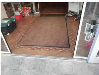
Windfang am Haupteingang
