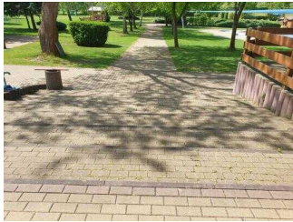
Weg von Rampe/ Treppe am Eingang zur Liegewiese / Schwimmbecken
