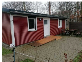
Weg vom Parkplatz zum Eingang Ferienhaus Nr. 21
