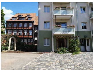
Weg vom Parkplatz zum Eingang mit Stufe
