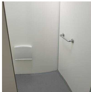
Haltegriff und Duschocker in der Dusche
