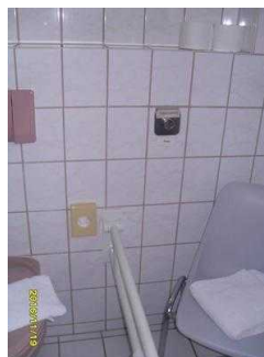
Duschbereich mit Duschsitz und Haltegriffe
