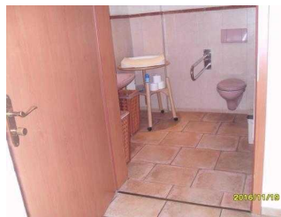
Blick durch die Tür ins WC
