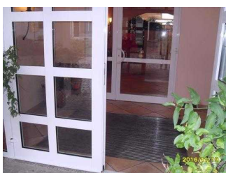
Windfang Haupteingang Straßenseite
