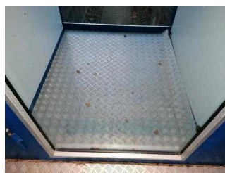
Außenaufzug zur Ebene Ferienhäuser
