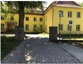
Weg vom Parkplatz zur Rampe Nebeneingang
