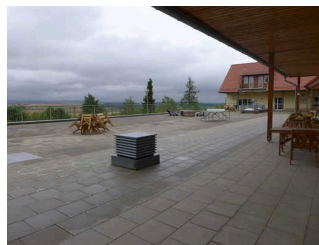
Weg zum Haupteingang über Außenterrasse
