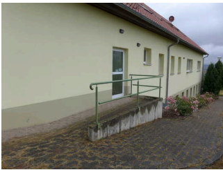
Hintereingang mit Rampe
