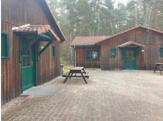
Bungalow 16 und 17 (baugleich): Eingangsbereich
