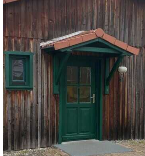
Bungalow 16 und 17 (baugleich): Eingangsbereich
