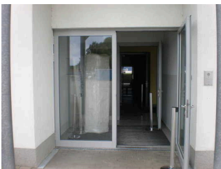
Tür Windfang außen zum VIP-, Veranstaltungsbereich Ebene 0
