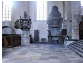
rechts im Bild Zugang zur Bischofskapelle (Blick ohne Baumaßnahme)
