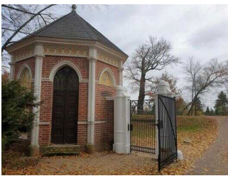
Torhäuser am Eingang Nordtor
