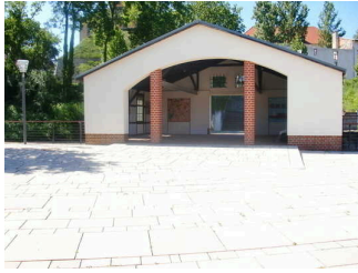
Eingangsbereich über Brückenhaus
