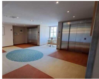
Aufzug in den oberen Etagen
