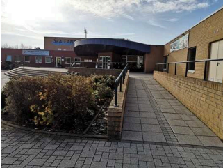
SeaLand: Rampe am Eingang
