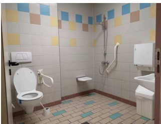
SeaLand: Umkleide und WCs mit Duschen für Menschen mit Behinderung
