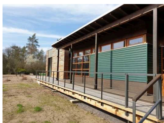
Weg von Eingangstür Außengelände zum Eingang Auenhaus
