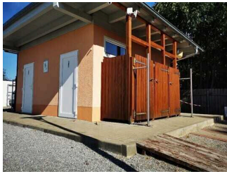
Rampe an den Umkleiden im Außenbereich
