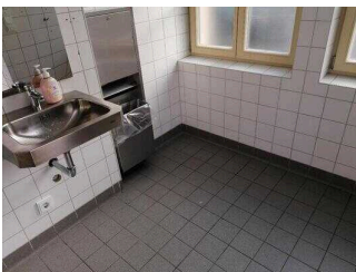
Außengebäude: Öffentliches WC für Menschen mit Behinderung
