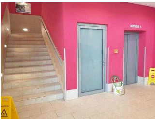
Treppe zum Bad-Saunabereich
