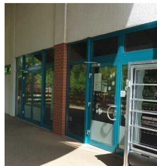
Zugang über die Terrasse
