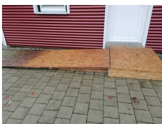
Rampe zum Ferienhaus Nr. 21
