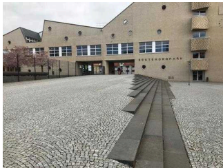
Rampe auf dem Verbindungsweg zwischen Bestehornpark und Stadtpark
