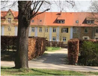
Rollstuhlfahrer erreichen das WC stufenlos nur über diesen Rampenweg.
