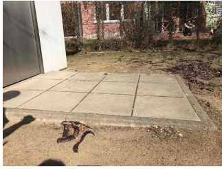
Rampe am WC-Eingang an der Eine-Terrasse
