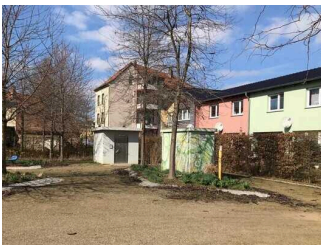
Eine-Terrasse: Eingang öffentliches WC für Menschen mit Behinderung
