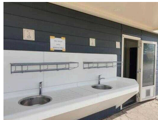
Außenbereich am Hauptsanitärgebäude: Waschbecken
