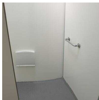
Haltegriff und Duschhocker in der Dusche
