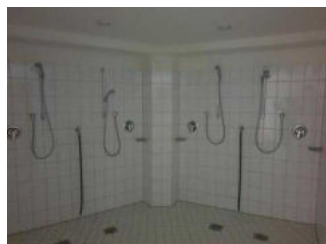
EG: Duschen im Saunabereich
