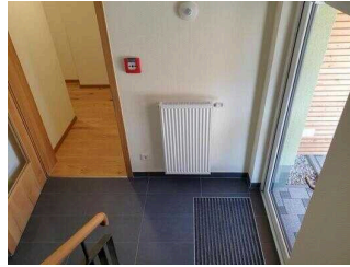
Gästehaus: Tür zum Zimmerflur
