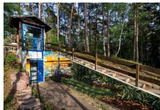
Außenaufzug zur Ebene Ferienhäuser/ Mehrweckgebäude
