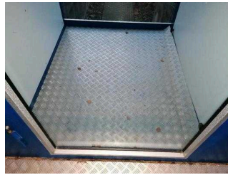
Außenaufzug zur Ebene Ferienhäuser
