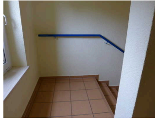
Zwischenfläche Treppe vom Erdgeschoss ins Untergeschoss
