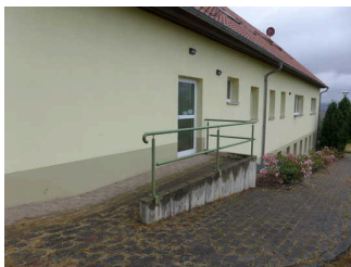
Rampe am Hintereingang
