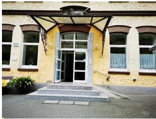
Eingangsbereich mit Rezeption
