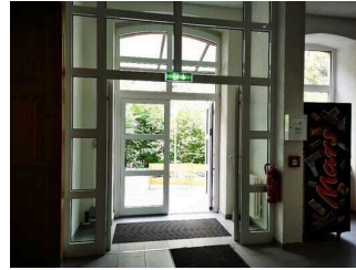
2. Eingangstür im Windfang
