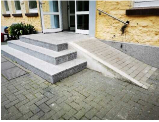
Rampe am Haupteingang
