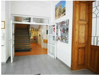
Weg vom Eingang zum Treppenhaus
