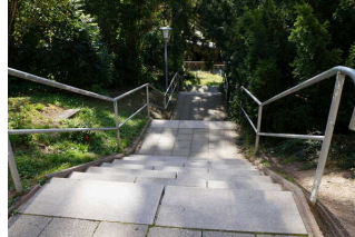
Treppe außen zum Eingang 3. Abschnitt
