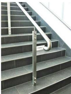
Der Handlauf im EG wird über die Vorderkante der Antrittsstufe nicht horizontal weitergeführt.
