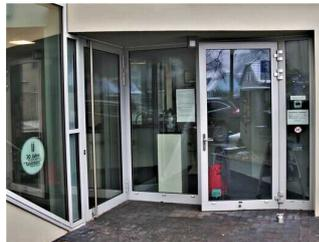
Die Eingangstür ist aus der Fassade etwas zurückgesetzt. Dadurch ergibt sich ein gewissen Regenschutz. Sie schlägt nach außen auf.
