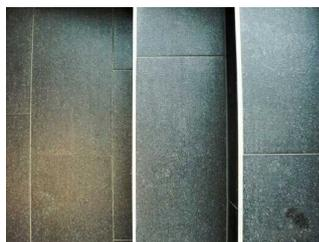
Zwischen der letzten Stufe des Treppenabganges und dem angrenzenden Fußbodenbelag im EG besteht kein visueller Kontrast.
