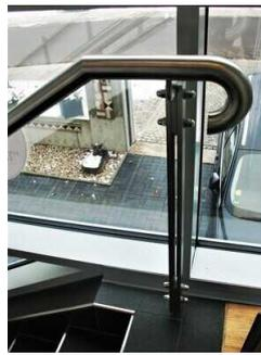
Der Handlauf (Bereich Außenfassade) wird im 1. OG horizontal weitergeführt.
