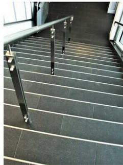
Die Vorderkanten aller Stufen sind optisch kontrastierend ausgeführt.
