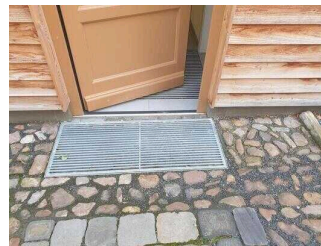
Stufenloser Eingang Klostercafé / gleichzeitig Eingang Sanitärgebäude
