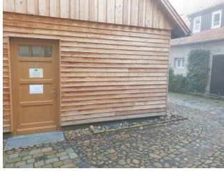
Eingang ins Sanitärgebäude
