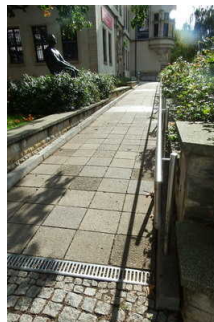
Rampe zum Eingang
