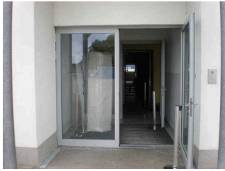
Tür Windfang außen zum VIP-, Veranstaltungsbereich Ebene 0
