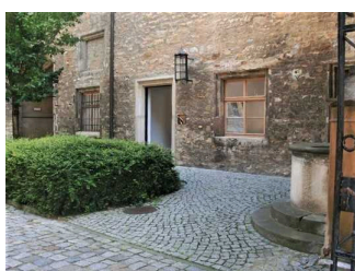
Eingang ins Sanitärgebäude
