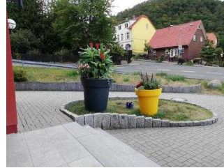
Rampe von der Zwischenplattform zum Eingang
