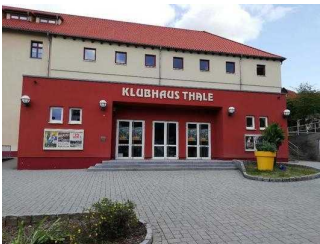
Rampe von der Zwischenplattform zum Eingang
