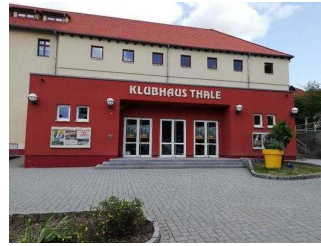
Weg von der Zwischentreppe zum Eingang
