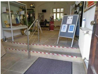
Treppe am Haupteingang (innen)
