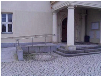
Treppe am Nebeneingang
