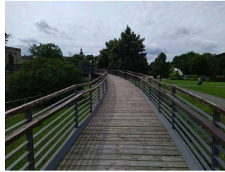
Rampe 3 vor Brücke
