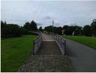
Rampe 3 vor Brücke
