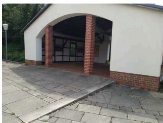
Rampe 1 vor dem Eingang über Brückenhaus
