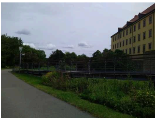
Rampe 3 vor Brücke
