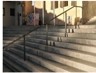
Treppe auf der Freifläche
