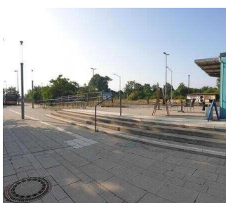
Zugang mit Treppe und Rampe
