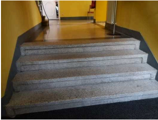
Stufen am Eingang innen (Bestehornhaus mit Veranstaltungssaal)
